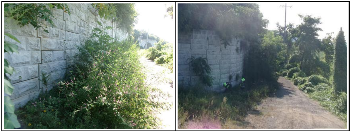
【사진 7.3.1】 지반, 기초부 전경
