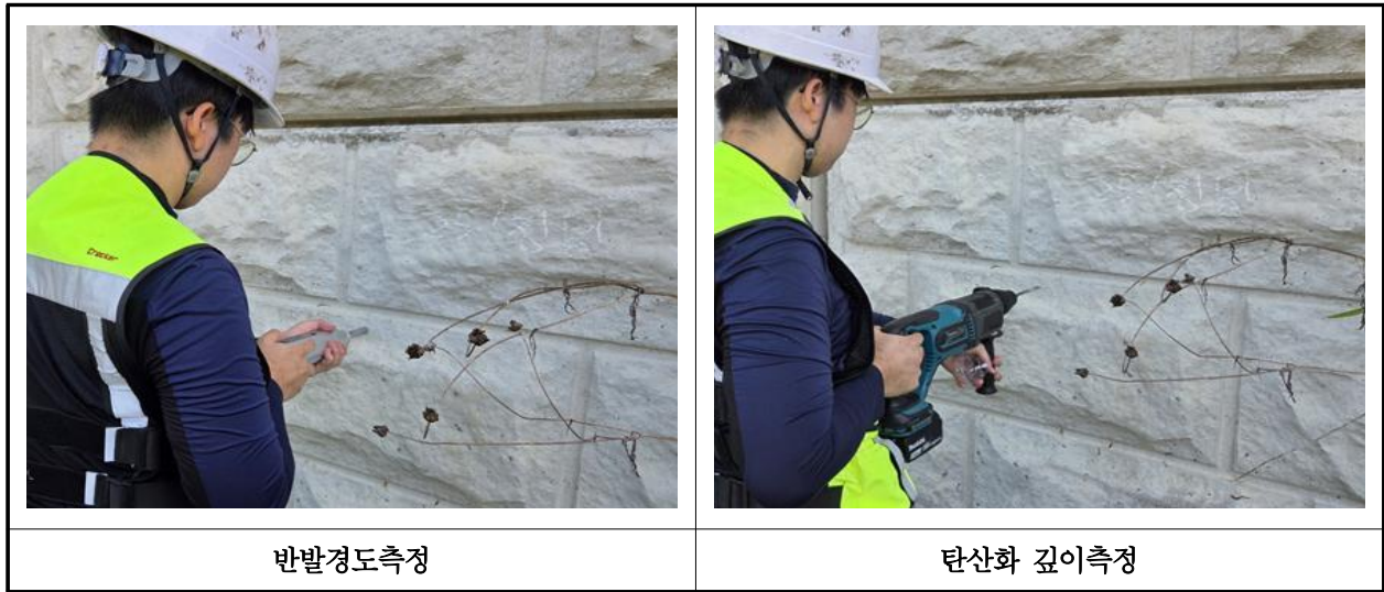
【사진 7.4.1】 재료시험 조사 전경
