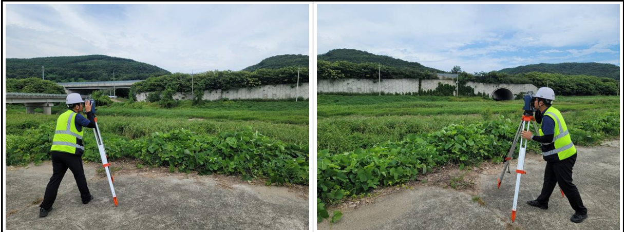
【사진 7.4.2】 측량작업 전경
